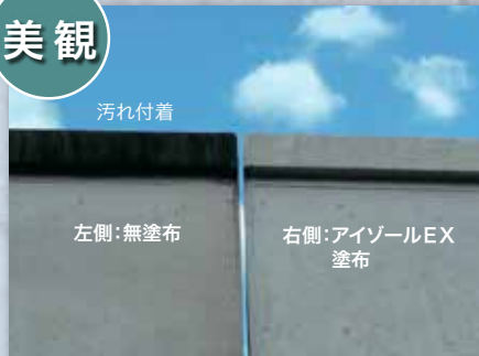
高架橋 施工後9年
