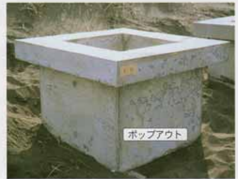
非塗装供試体 ポップアウトが発生している
