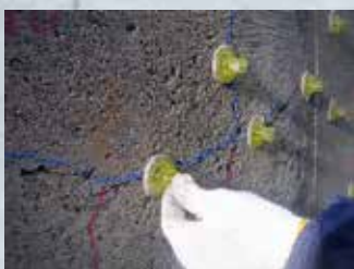
座金設置状況
