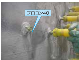
プロコン40先行注入の状況
