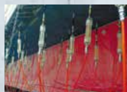
床版下面施工
