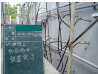
擁壁のASR補修事例
