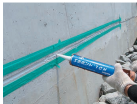
▲ひび割れへエポボンド1CHを使用
