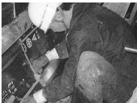
▲シールド工事の1次止水にボンドトップWAを使用
