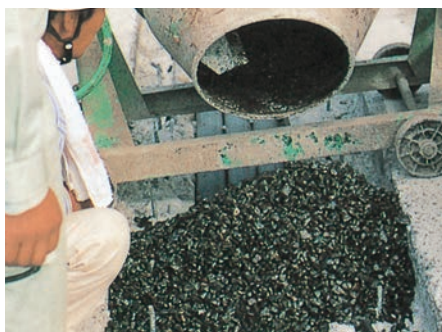
▲透水性水路にEB-42PSグレー(樹脂のみ)を使用
