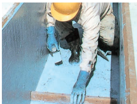
▲水路橋の保護モルタルとしてEB-42を使用
