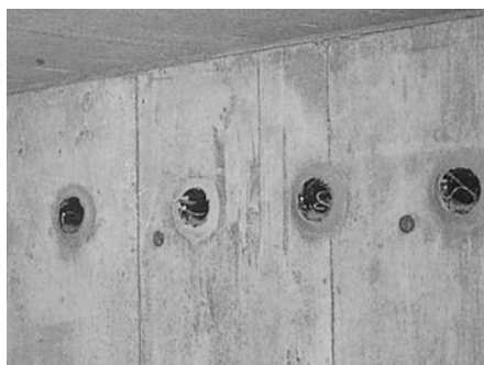
▲ベルマウス取付け部にボンドトップWGを使用
