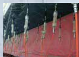
床版下面施工
