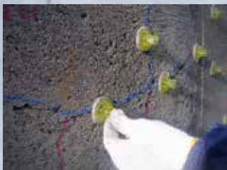
座金設置状況
