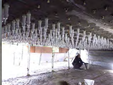
ひび割れ注入 (低圧注入工法)
