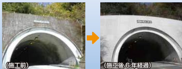
(高知県 塚地坂トンネル クリアーでの施工)
