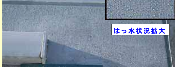
既設建築物の外壁塗布事例 12ヶ月経過 (散水後のはっ水状況)
