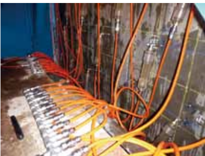
リハビリカプセル工法施工状況
